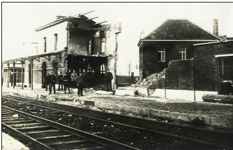
Het vernielde station van Hansbeke. Enkele werkmannen staan klaar voor de eerste afbraakwerken.
