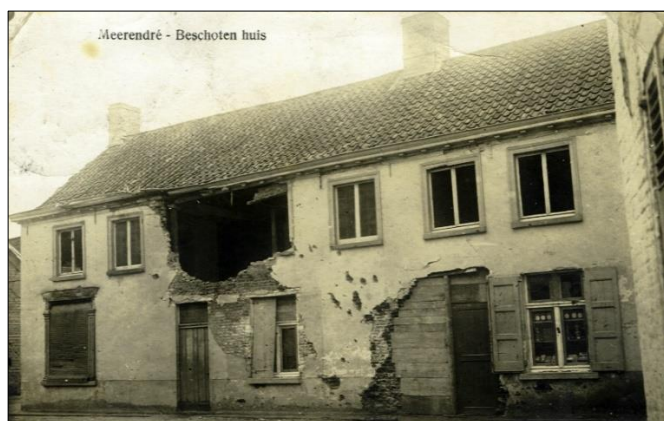
Beschadigde woning in het dorp van Merendree.
